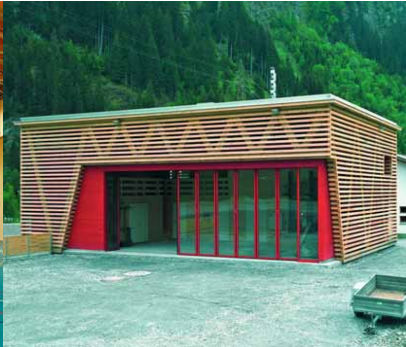
Entrepôts des services forestiers et de la commune de Safien en bois massif FSC, Architectes Albertin et Zoanni
