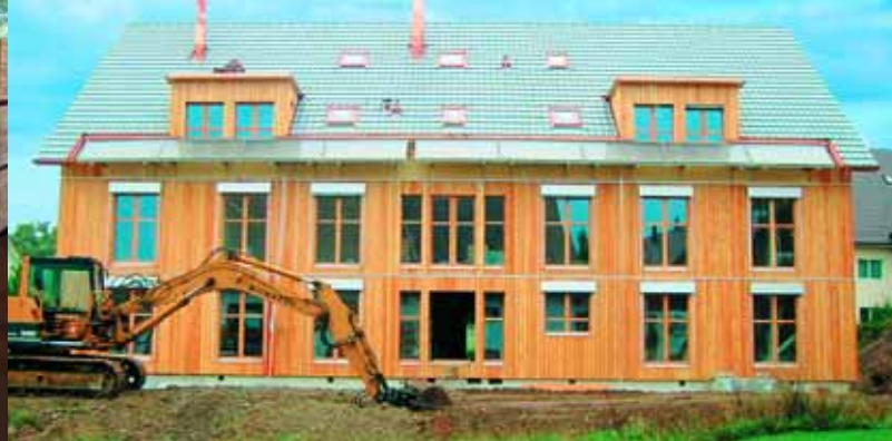
Portes en bois FSC (en haut) Villas mitoyennes en bois FSC à Hettlingen (ZH), Werkstatt für Architektur und Planung (en bas)
