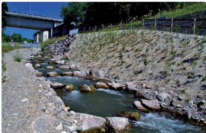
Le scale per pesci della centrale di Wettingen sono adatte anche ai pesci più piccoli.
