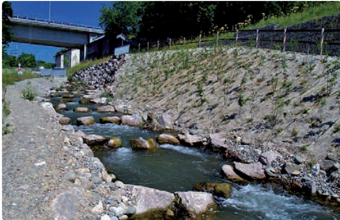
Der Fischpass des Kraftwerks Wettingen funktioniert besonders für Kleinfische gut.
