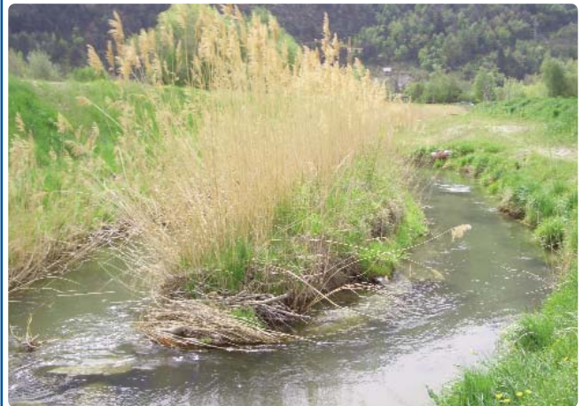
Manutenzione più economica per il canale Galdi rivitalizzato (VS)
