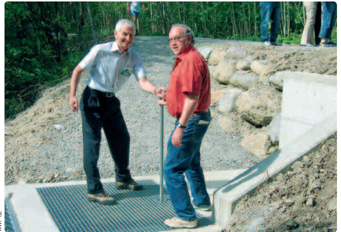
WWF-Präsident Robert Bachmann (rechts) und Matthias Luchsinger, Verwaltungsratspräsident der Kraftwerk Feusisberg AG, öffnen den Schieber anlässlich der offiziellen Einweihung.
