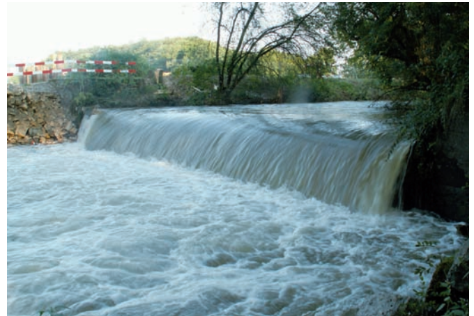
Les centrales hydrauliques à tourbillons requièrent des obstacles artificiels à la migration de plus de 50 cm de haut.
