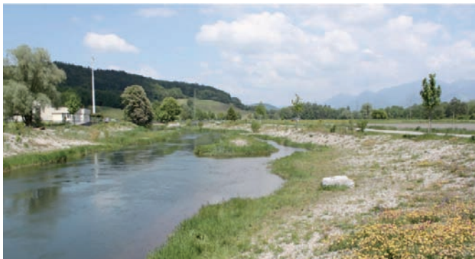
Les centrales hydrauliques à tourbillons ne doivent pas empêcher les revitalisations.
