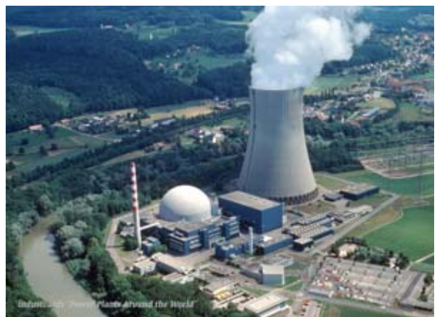
Centrale nucléaire 970-MW, Gösgen, CH
