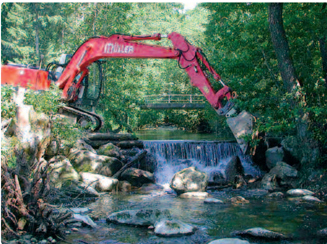
Revitalisierungsmassnahme: Entfernung der Schwelle
