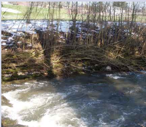
Fascine di salice sul Wyna
