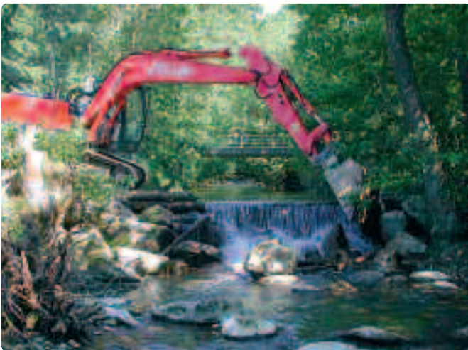
Attività di rivitalizzazione: rimozione delle traversine
