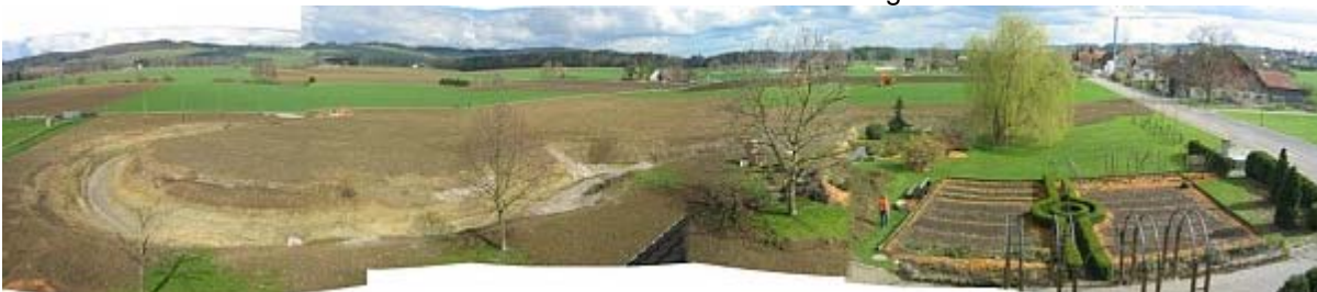
Veduta panoramica del progetto al termine dei lavori di sterro il 28.3.2005
